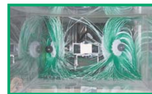
Pinion Y, pentru rotația a 2 perii în conducte rectangulare
